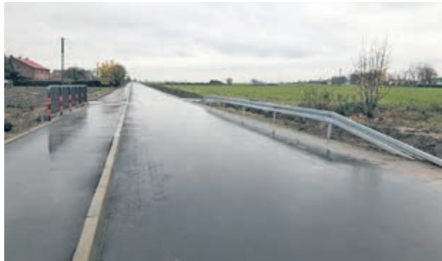
Przebudowa drogi w miejscowości Janów
